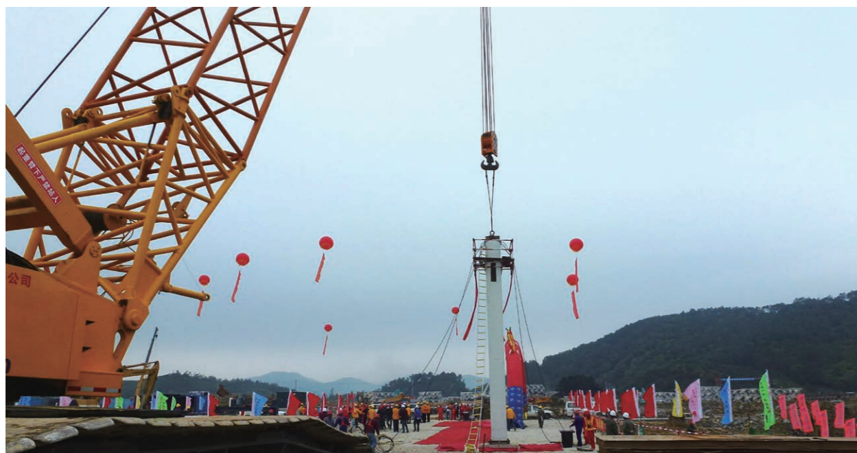
『 4月28日，华润电力（海丰）发电有限公司一期2×1000MW超超临界燃煤发电机组2号炉钢架吊装。』
