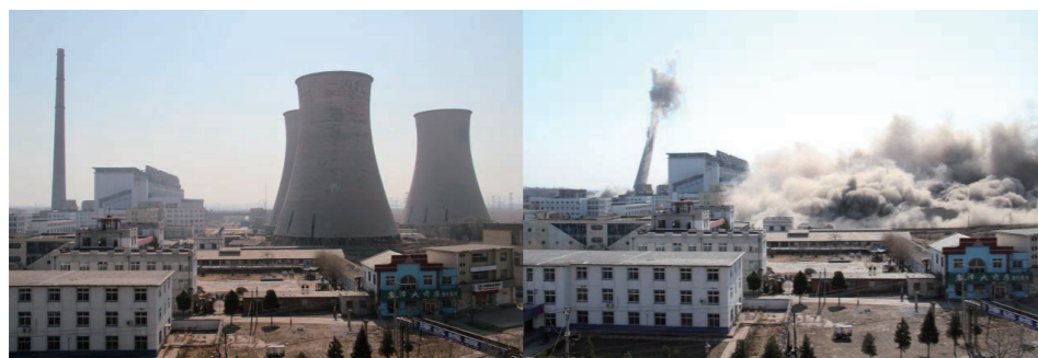
『 锦州电厂原有6台200MW燃煤纯凝发电机组，能耗高、污染重，随着国家节能减排、上大压小等政策的实施，该厂于2009年10月31日至2013年9月1日相继关停老机组。图为爆破拆除老机组的冷水塔和烟囱。』
