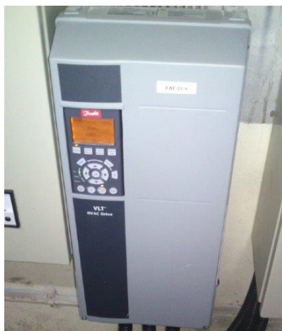
全栋大厦风柜及新风机加装变频器
