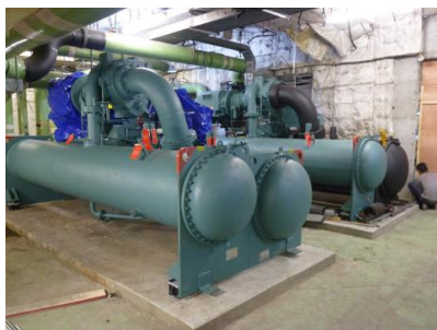
明泰大厦更换两台制冷主机
