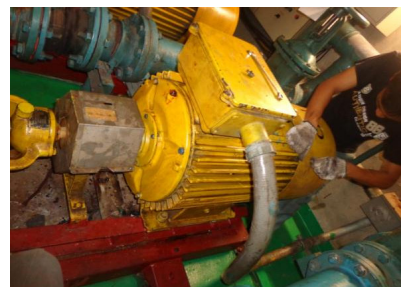
大厦设备维修
