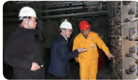
华润电力春节前安全大检查
